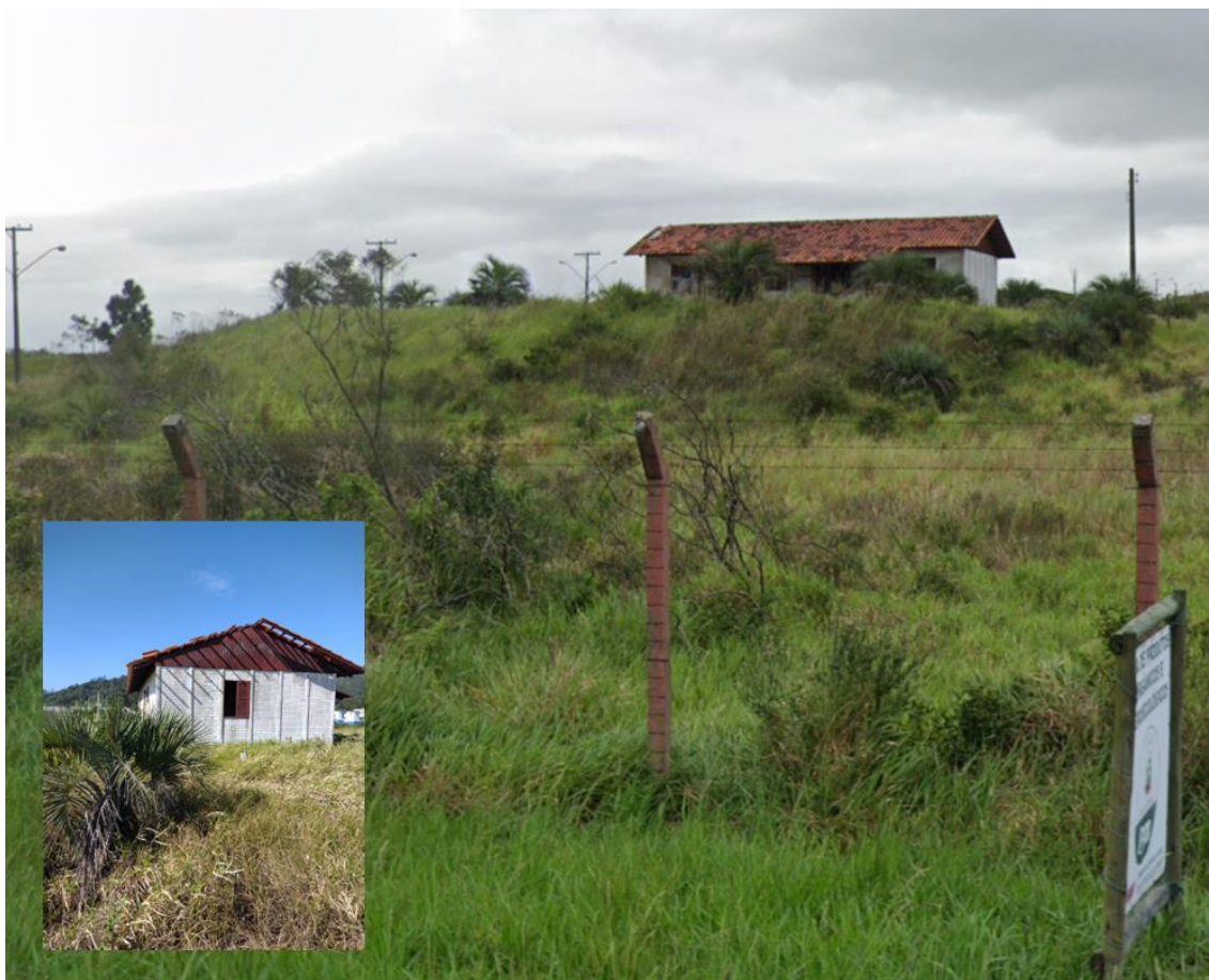
Figura 5: Edificação 1 existente na área da ZPE Imituba.
