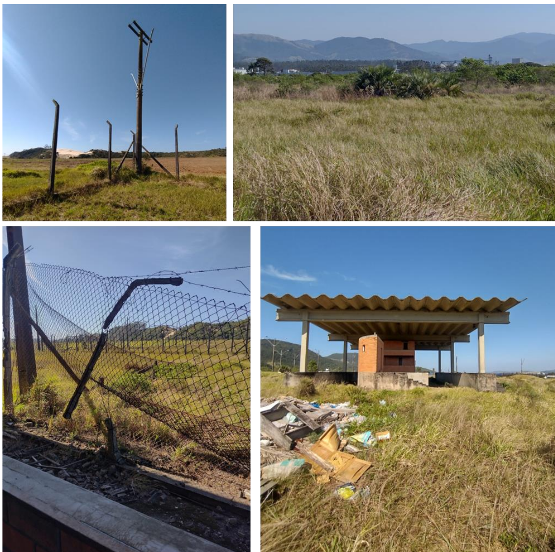
Figura 7: Aspectos do terreno da ZPE e estado de conservação de benfeitorias.
